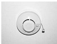
天井取付 煙式
