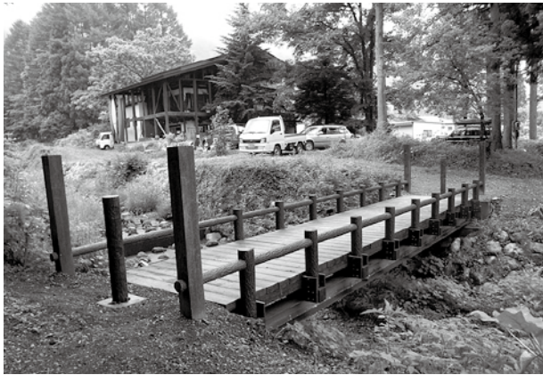
かたくり橋修繕
