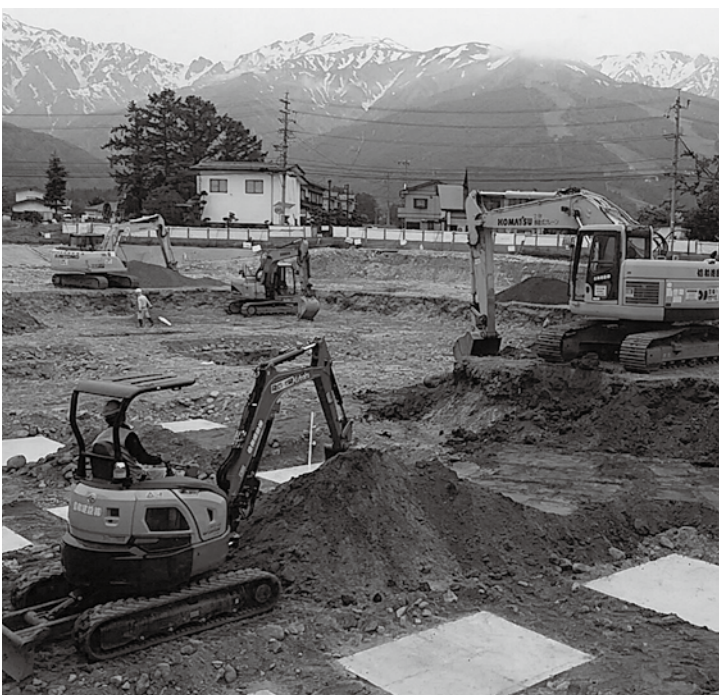
建設中の給食センター（床固め工事）
