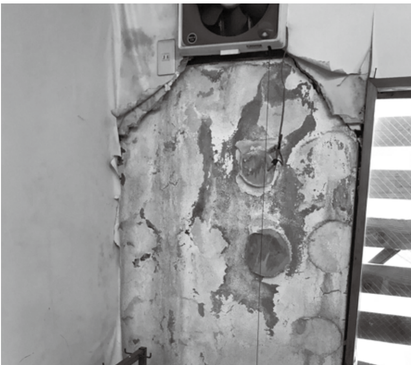
老朽化の進んだ北小校舎。小規模改修でまかなえるのか。校舎統合も含めて学校のあり方を議論していく必要がある。
