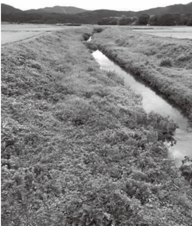
姫川堤防の草刈は過酷な作業
