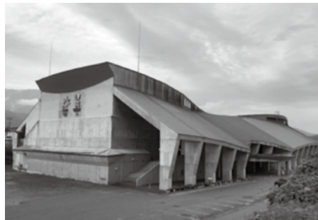
残念ながらウイング21は建設以来雨漏りが続いている。抜本的な対策の必要性と、公共事業における設計・監理の大切さが問われる。
