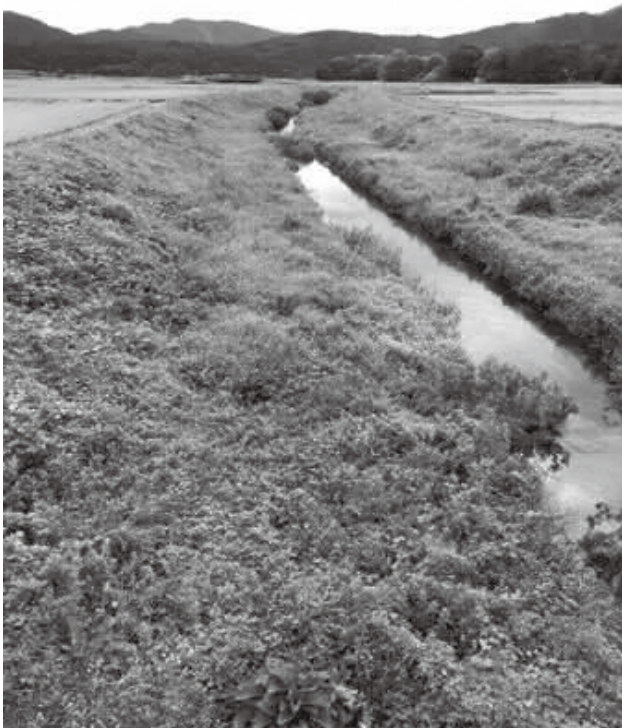
姫川堤防の草刈は過酷な作業
