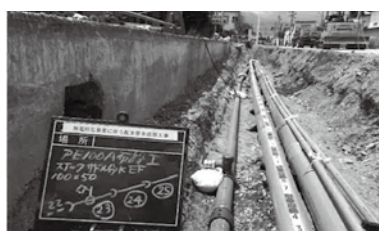
無電柱化に伴う布設替工事(県道)
