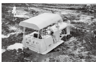
昭和55年頃 県営ほ場整備事業神城地区 (埋没するブルドーザー)
