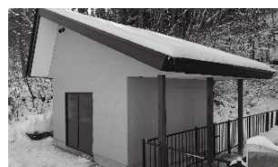
揚水機施設・揚水ポンプ
