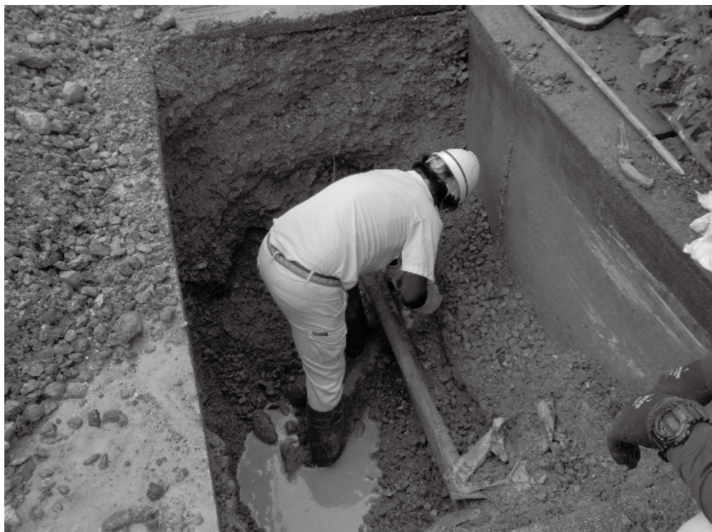
漏水修理工事の様子
