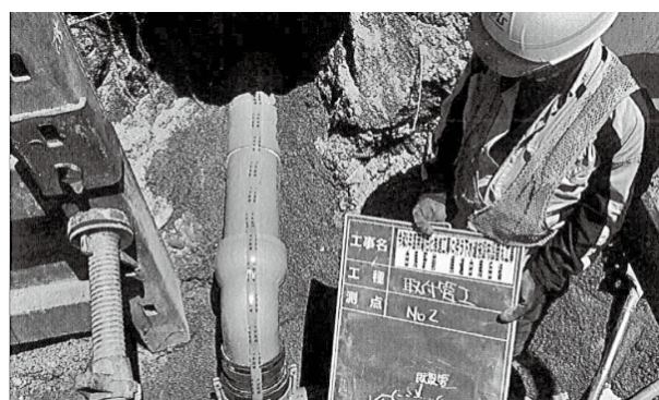
白馬駅前無電柱化に伴う下水道管布設替工事
