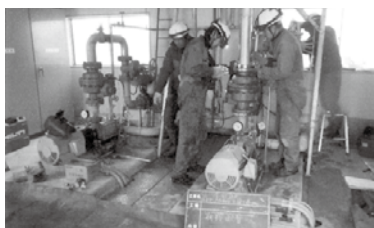
倉下ポンプ室電動弁更新工事
