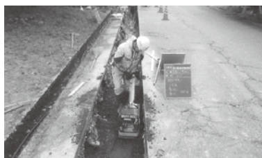
配水管布設替工事(めいてつ)
