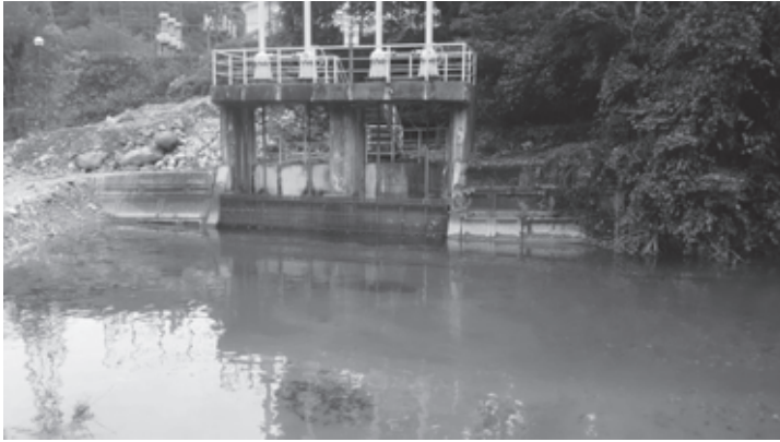
「二股水源」取水口の雪どけ水は透きとおっている
