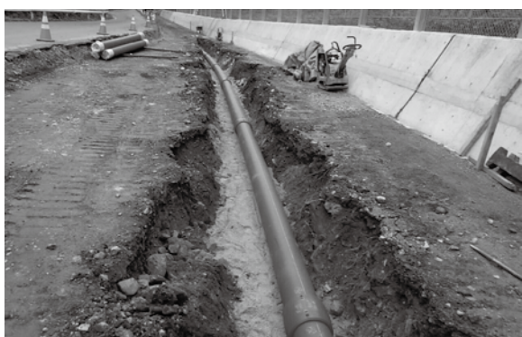
配水管布設替工事 (県道白馬岳線 二股)
