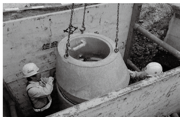
下水道施設布設替工事 (県道白馬美麻線 反田橋)
