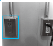
リーフ自体を蓄電池として活用 非常時の緊急用コンセントから電力を供給。 BCP対策としても強化されました。
