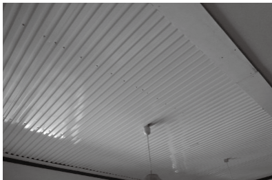
スチール波板にパイプを張り、温水天井 暖房を各客室に設置
