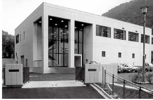
昭和57年竣工当時の二股浄水場
