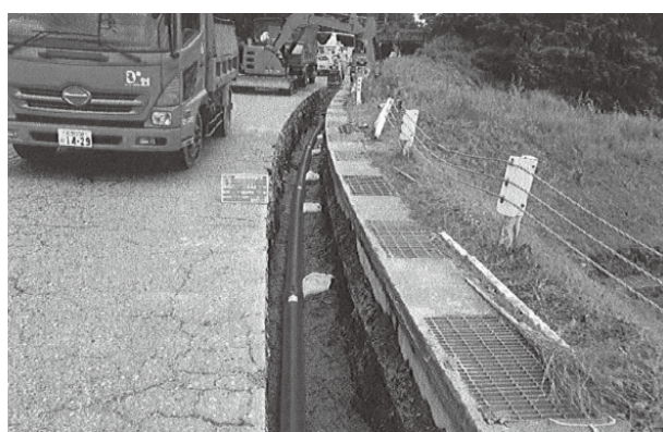
配水管布設替工事 (新田)
