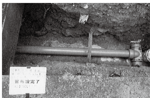
公共樹設置工事 (白馬町)
