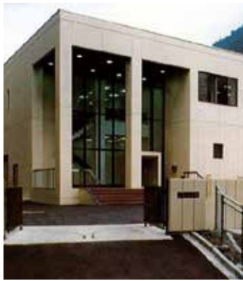
昭和57年竣工当時の二股浄水場
