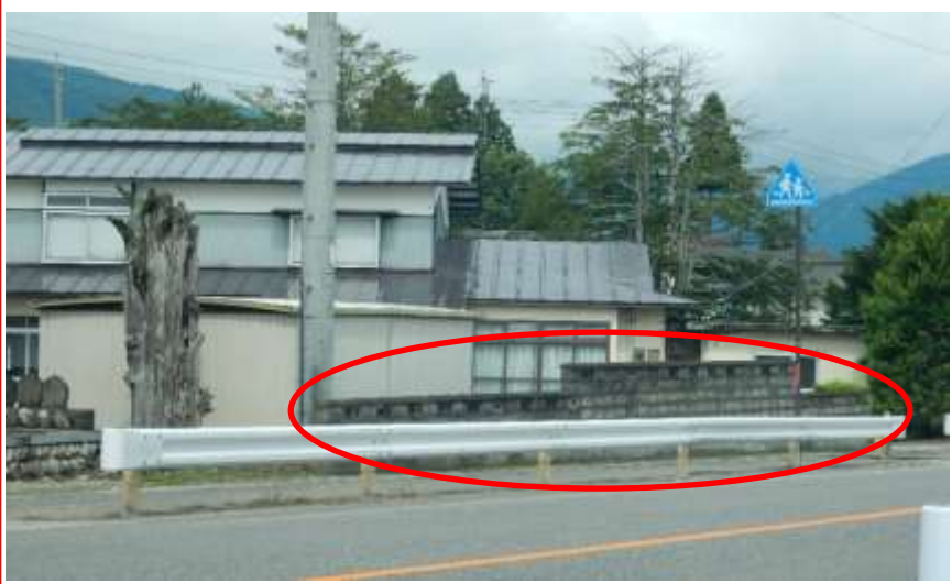
近江商会北側民家ブロック塀
