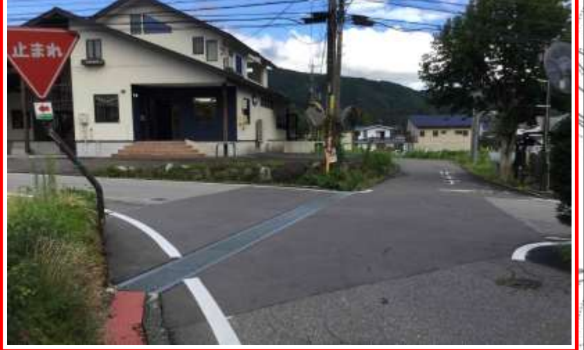
旧ジ・ゼル付近交差点・・・横断歩道の設置
