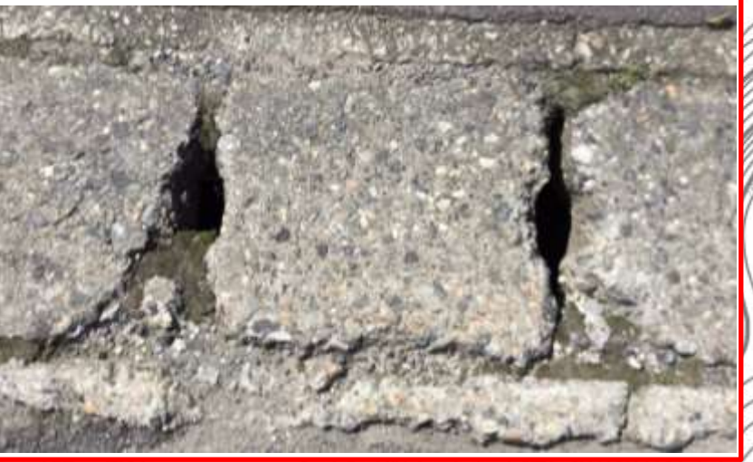
国道148号沿いの歩道・・・破損している側溝の修繕
