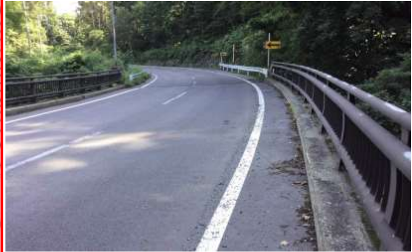
落倉区瀬戸の橋付近・・・歩道の設置、草木の伐採
