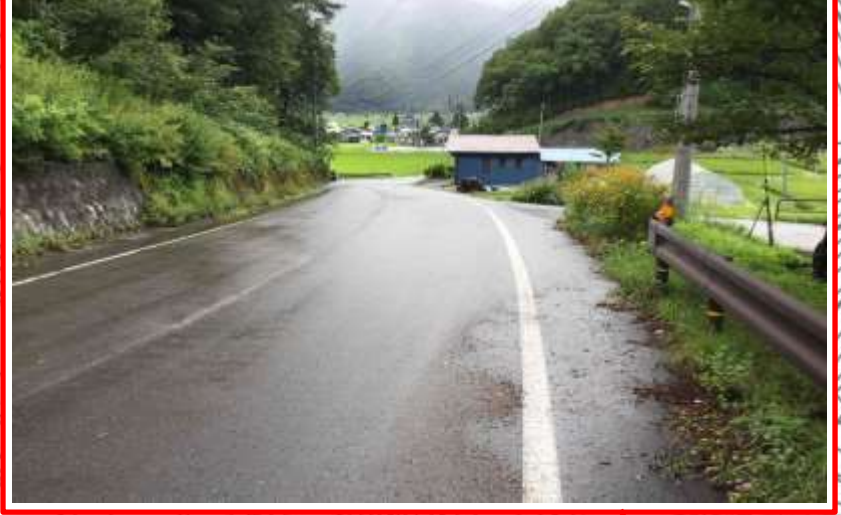
堀之内公営住宅東団地付近・・・歩道設置の要望
