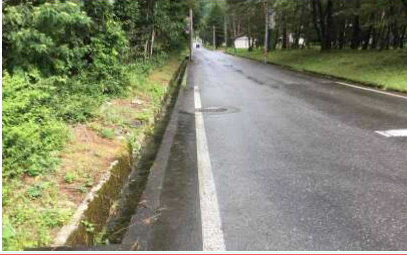
五輪道路から国道までの村道…グレーチングの設置
