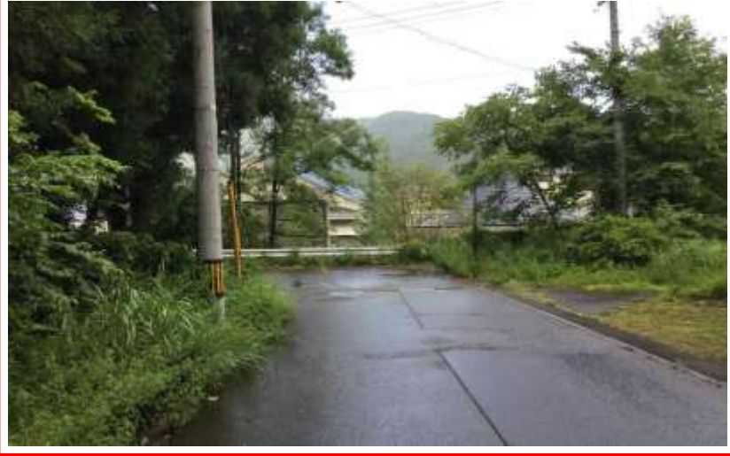
白嶺西側村道・・・急カーブの為カーブミラーの設置、草刈り
