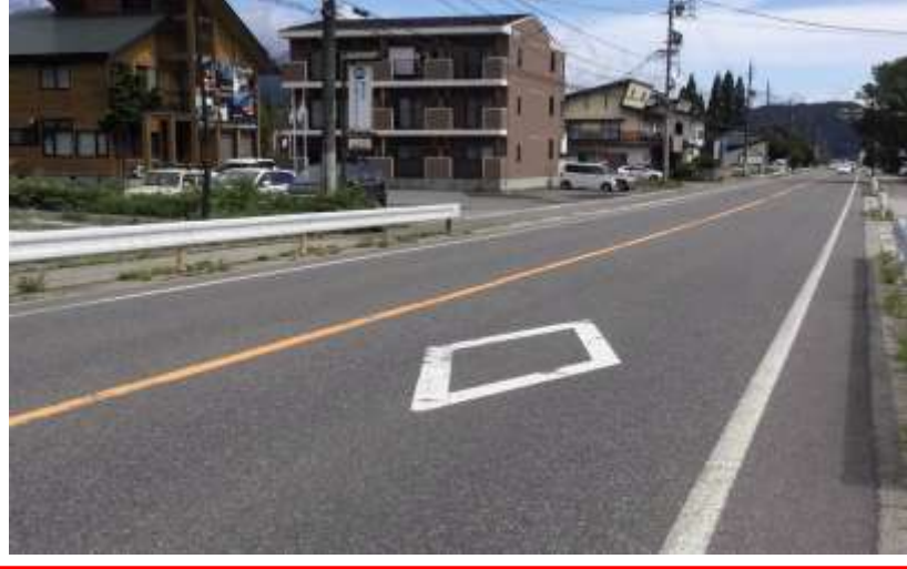
深空区国道歩道…ガードレールの設置
