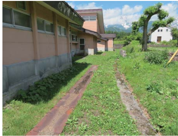
外部 雨水側溝
