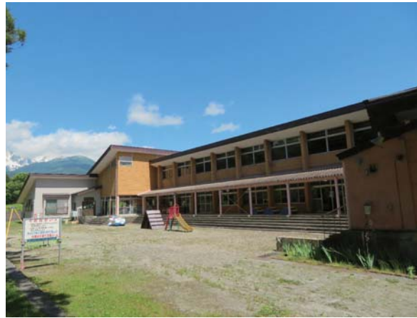
解体建物 外観
