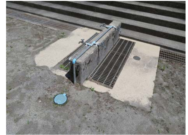
外部 園庭手洗い
