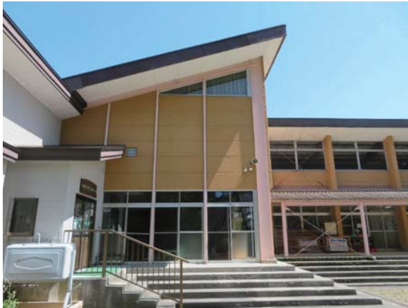
解体建物 外観
