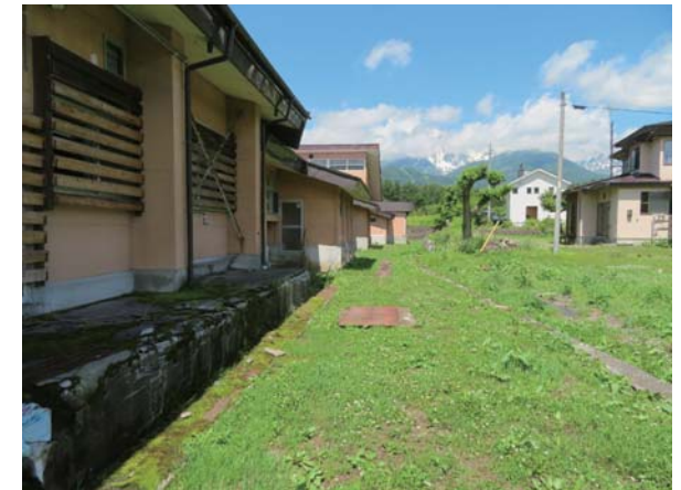
解体建物 外観
