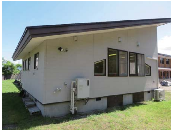
解体建物 外観
