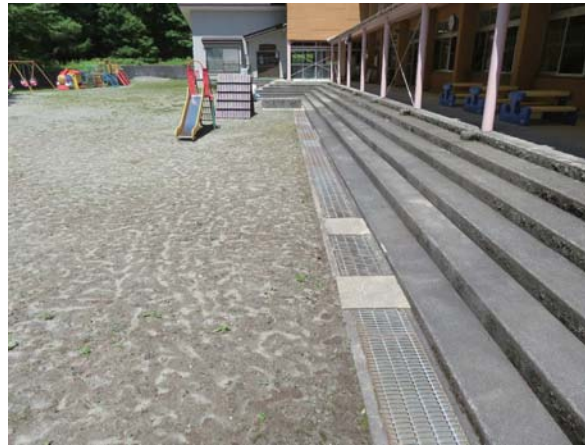
外部 園庭側溝
