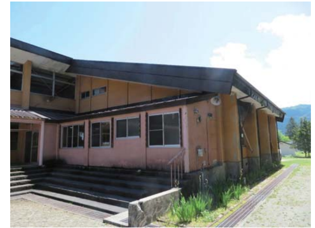
解体建物 外観
