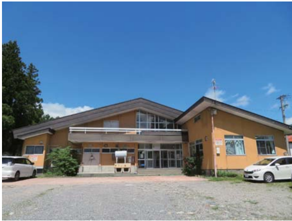
解体建物 外観
