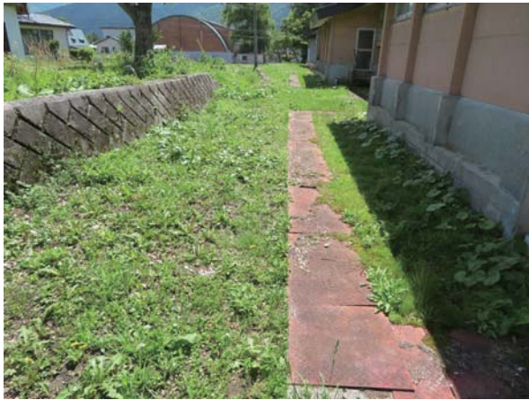
外部 雨水側溝
