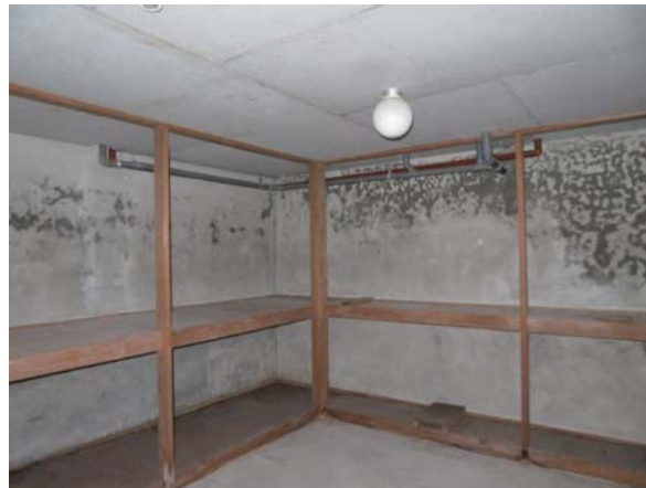
内部 地下倉庫
