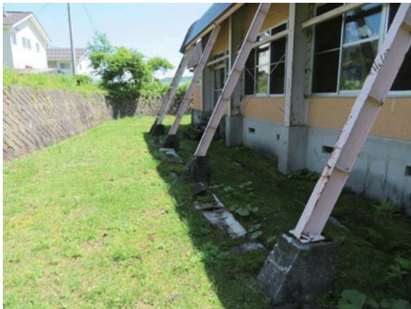
解体建物 外観
