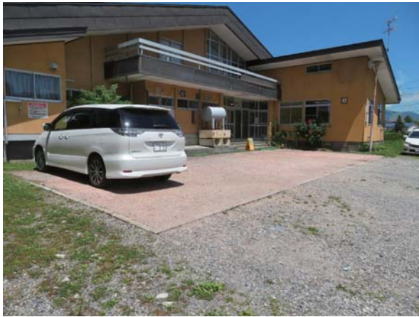
外部 コンクリート舗装
