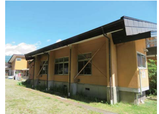
解体建物 外観
