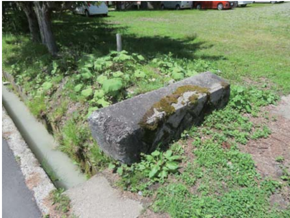
外部 既存擁壁
