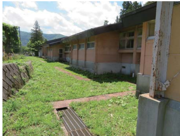
解体建物 外観
