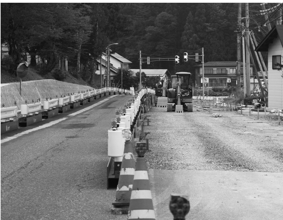
児童生徒を守る歩道（堆雪帯）工事と勾配改修工事 7月25日
