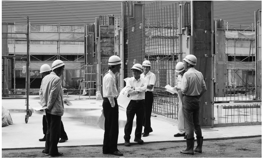
特別養護老人ホーム「白嶺」増床工事 9月21日
