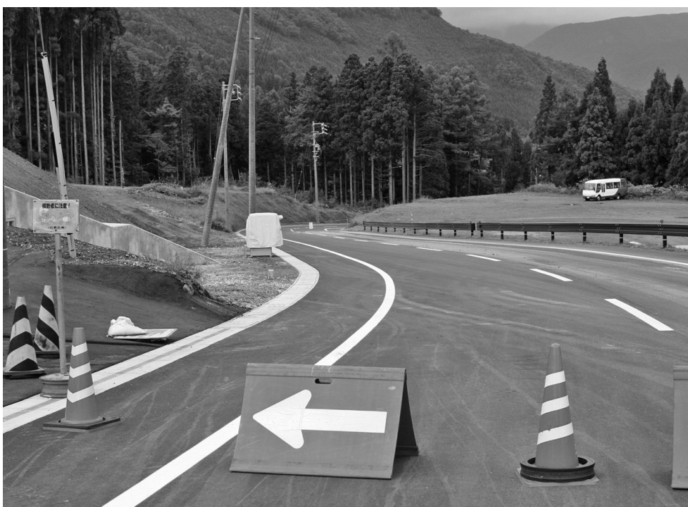
開通間近な神城山麓線 9月21日
