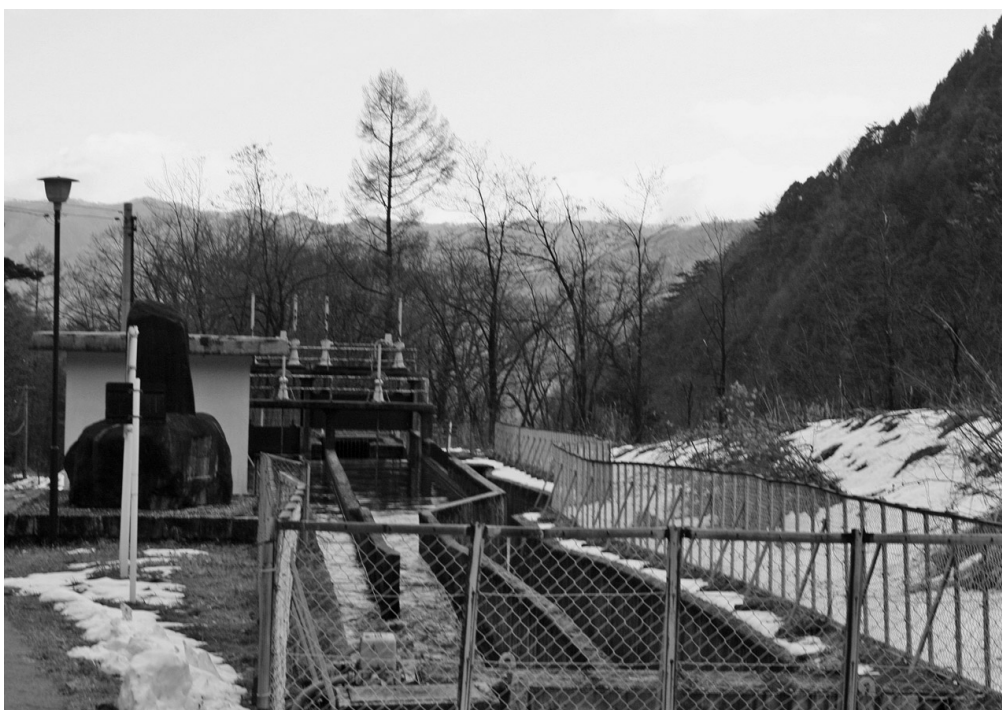
小水力発電施設建設予定地
