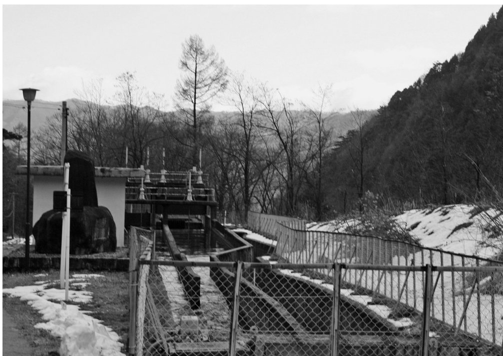
小水力発電施設建設予定地
