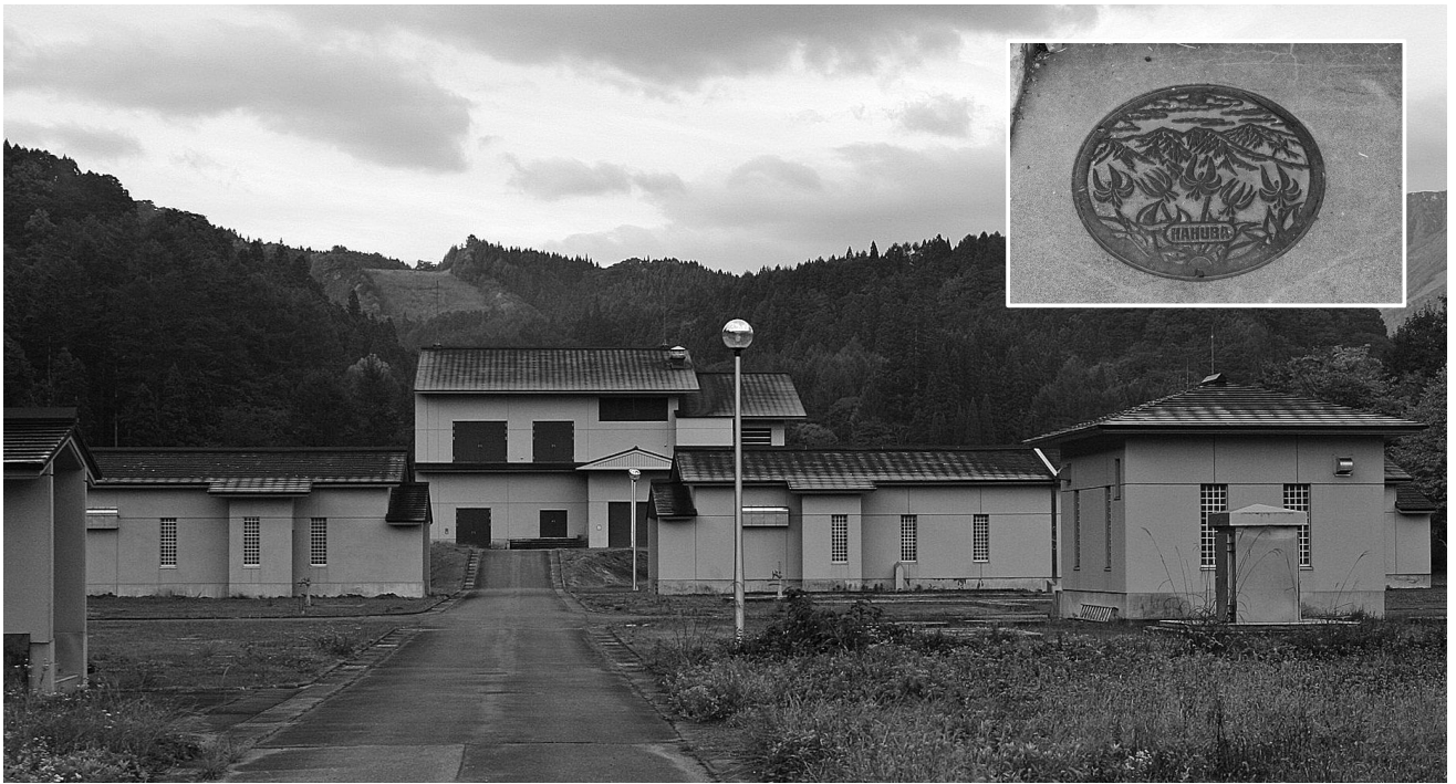
下水道マンホールと白馬村浄化センター（大出）
