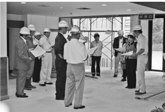
現場視察 白馬村デイサービスセンター（旧岳の湯改築）
