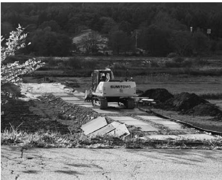
進む奈良井農道工事 10月27日
