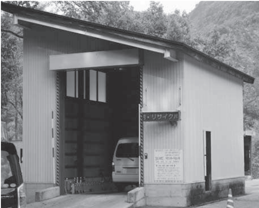
リサイクルセンター（清掃センター内）
