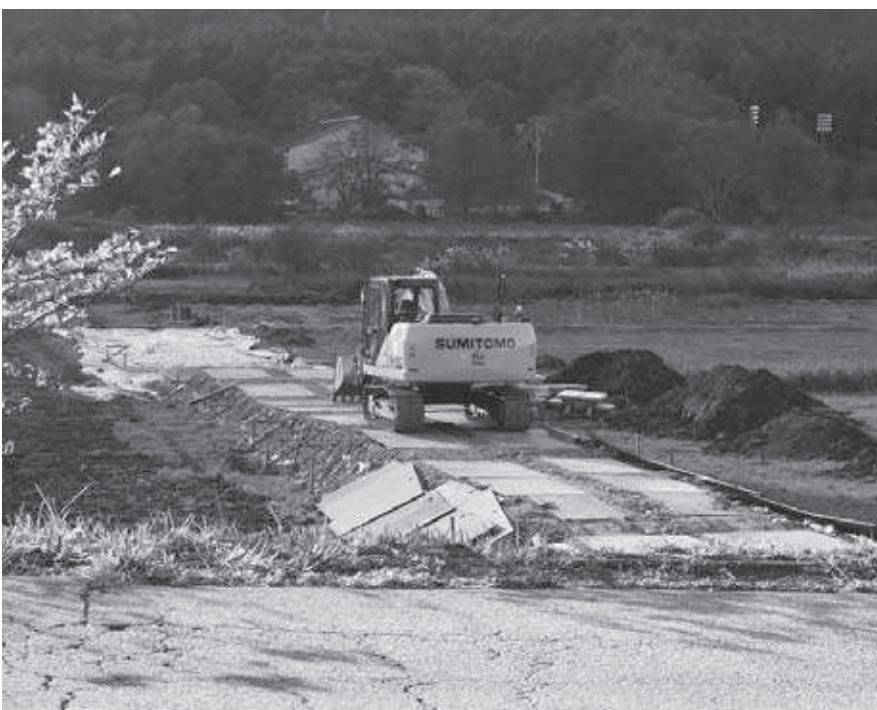
進む奈良井農道工事 10月27日
