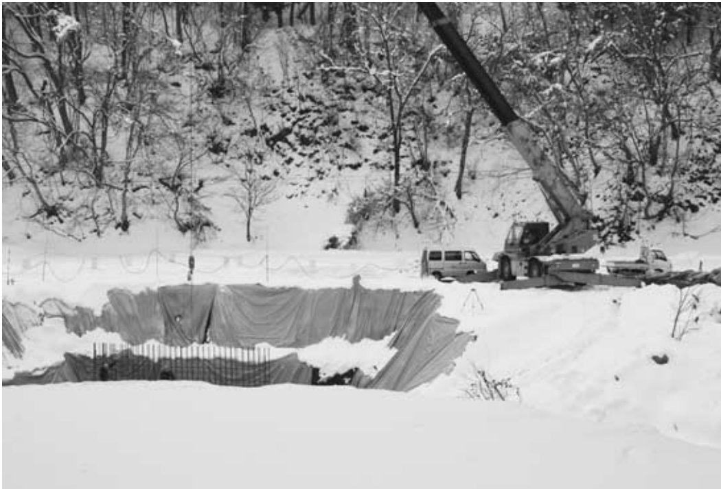
通地区 橋梁架け替え 平成26年完成予定
