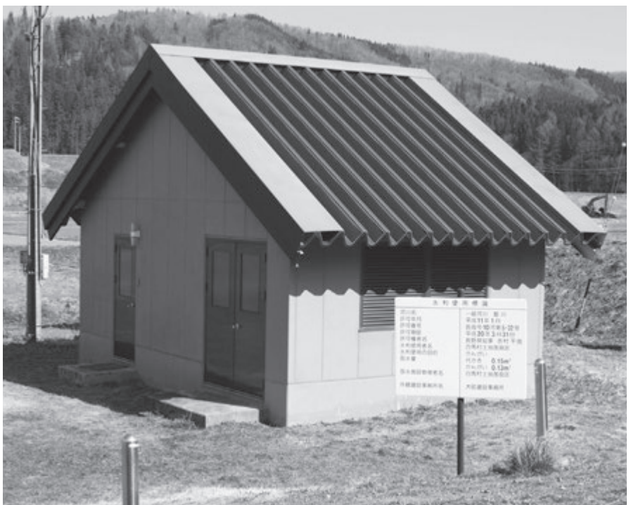
白馬村土地改良区 水揚げポンプ小屋
