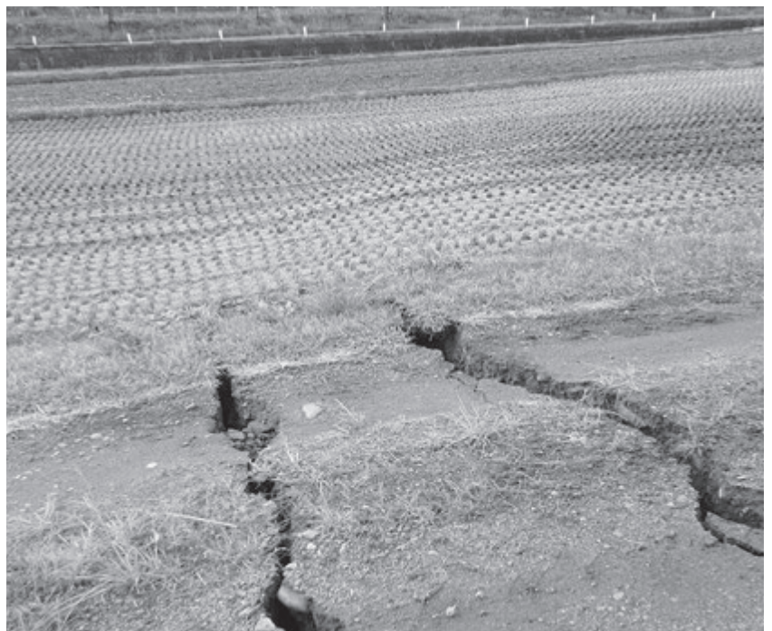
ひび割れ、隆起した農地(神城地区)
