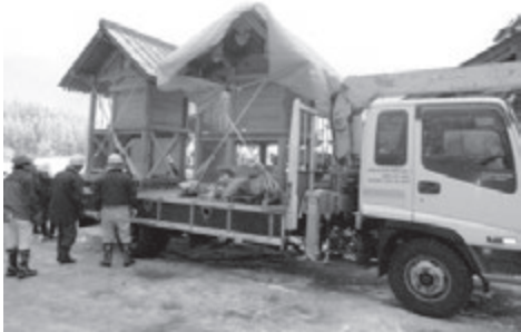
三日市場神明社は倒壊の恐れがあるため、一時移転をすることになりました。
