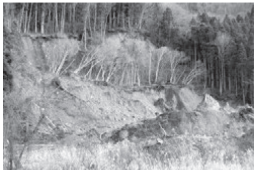
崩壊した山腹
