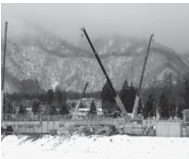
急ピッチで建設された仮設住宅
