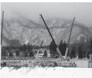
急ピッチで建設された仮設住宅
