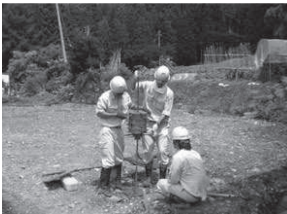
被災地の地盤調査がスタート
