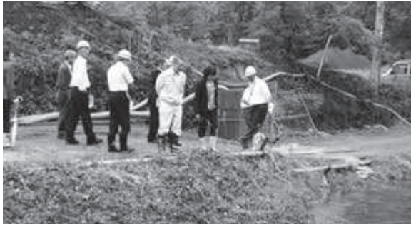
下水道の災害復旧工事現場を視察(塩島区)
