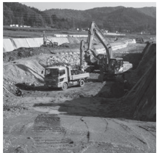
急ピッチで進む災害復旧工事
