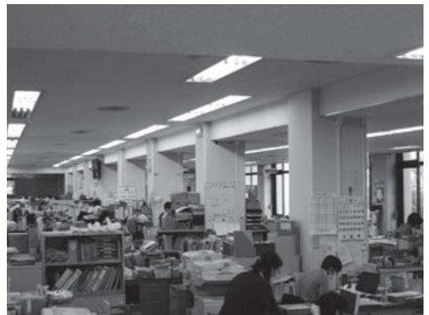
耐震改修で庁舎の改修が行われます
