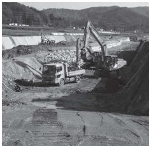
急ピッチで進む災害復旧工事
