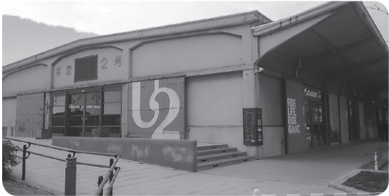
港沿いにある海運倉庫を改修してカフェやホテルが (onomichi U2 複合商業施設)
