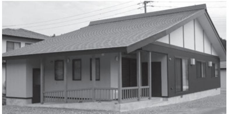
お年寄りの憩いの場に… 竣工したばかりの堀之内地区高齢者支え合いセンター
