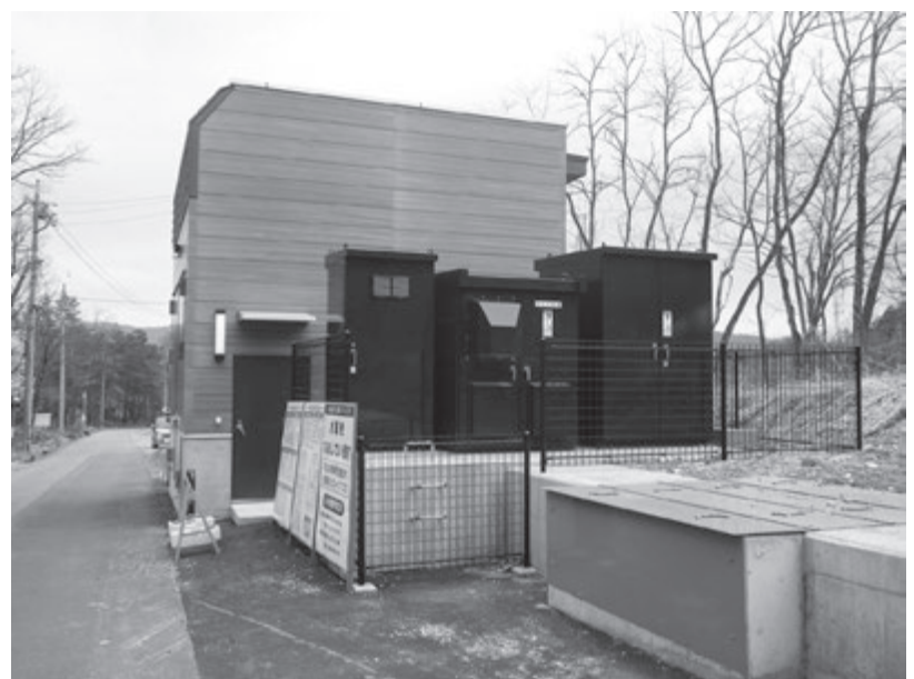
平川小水力発電所建屋(現在故障中)
