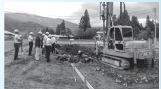
完成が待ち遠しい復興住宅 三日市場現場
