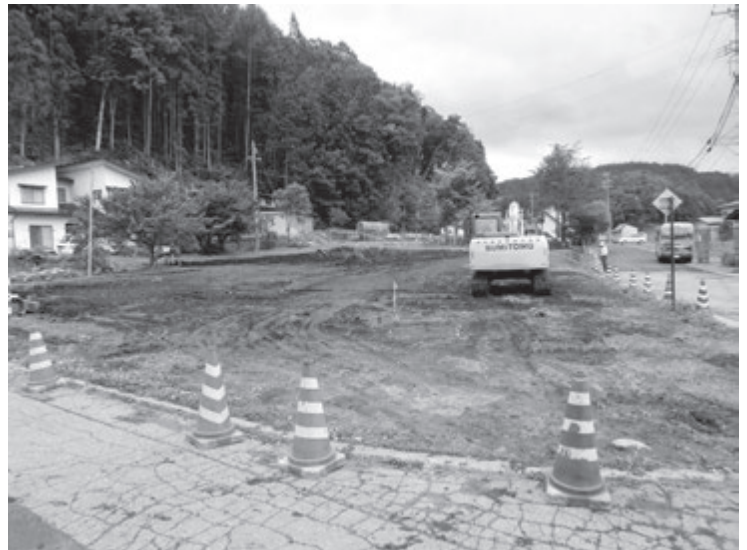
造成工事が進む復興住宅用地
