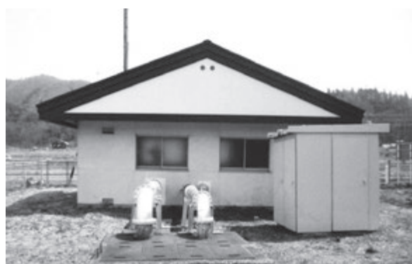
整備が必要な用水施設の内部(上)と外観(下)
