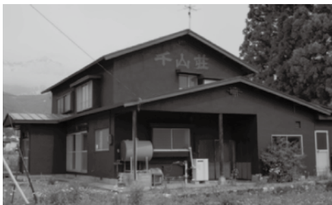
指針から外れた真っ黒な建物の事例 多くは外国人が買い取った建物で行われている
