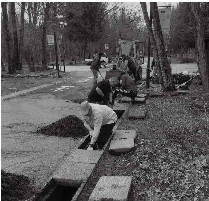
村道の側溝泥上げ作業に励む和田野区の住民。 行政区を支える担い手は、たいへん少なくなっている。
