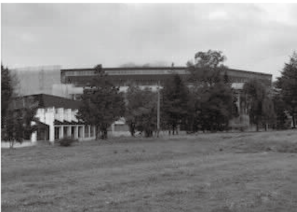
学校給食施設建設予定地〔中学校裏〕
