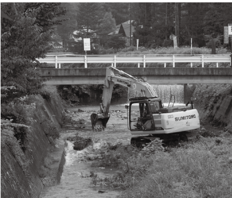
犬川にバックホーが入り、中洲の整備が行われた。これにより防災と、区民が川に入ったの草刈作業から解放
