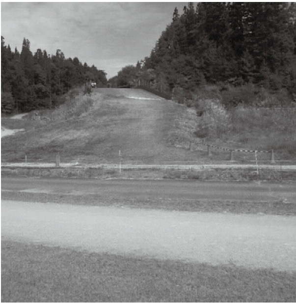
スノーハープのメインコース及び太鼓橋付近を東京オリンピック合宿誘致も視野に入れた改修工事設計。
