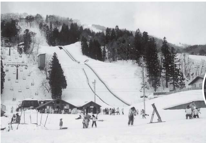
改修工事も終り本年度より使用できるようになったメディアムヒルジャンプ台
