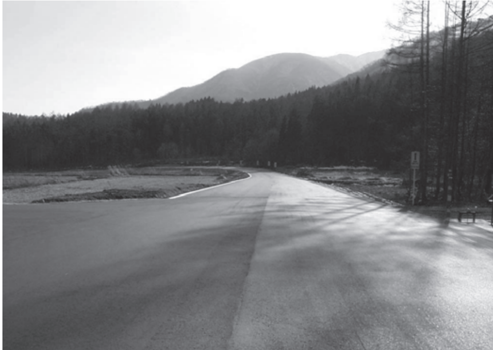
工事中の神城山麓線
